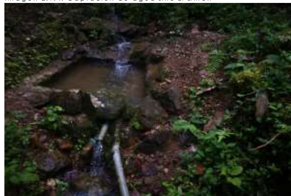
Imagen 2.1.4: Captación de agua sitio El Limón
